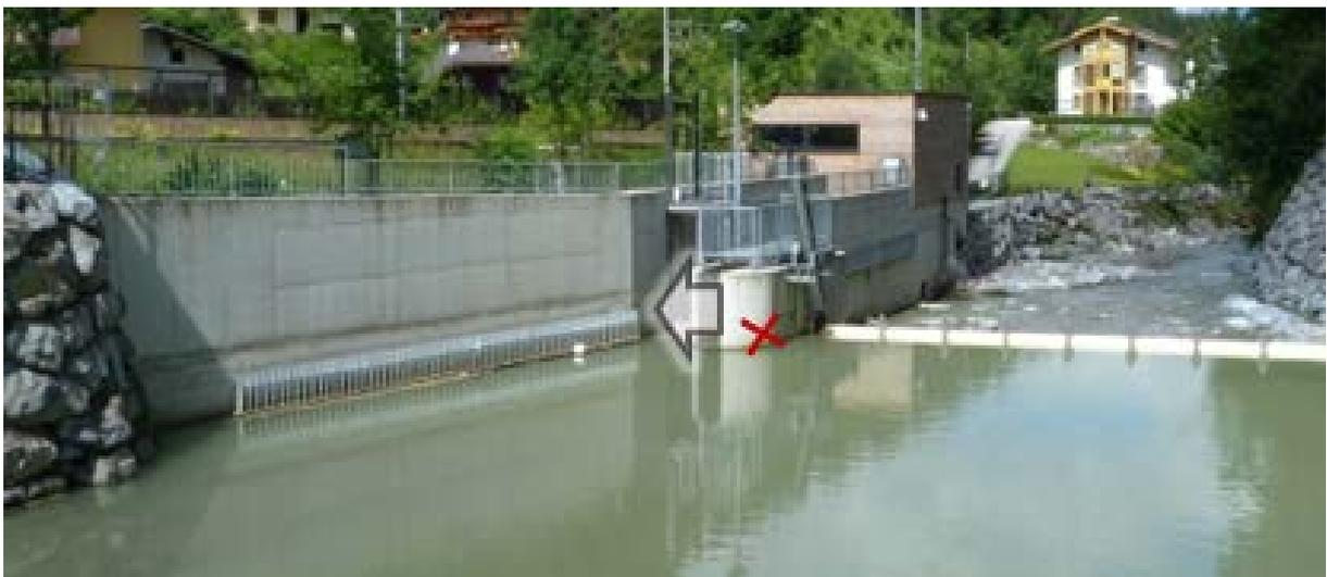
Abbildung 55: Variante zur Optimierung der Abstiegsklappe durch Versetzung an den Gewässerrand und Entfernung von Barrieren (Betonwand) entlang der Wehrachse.
