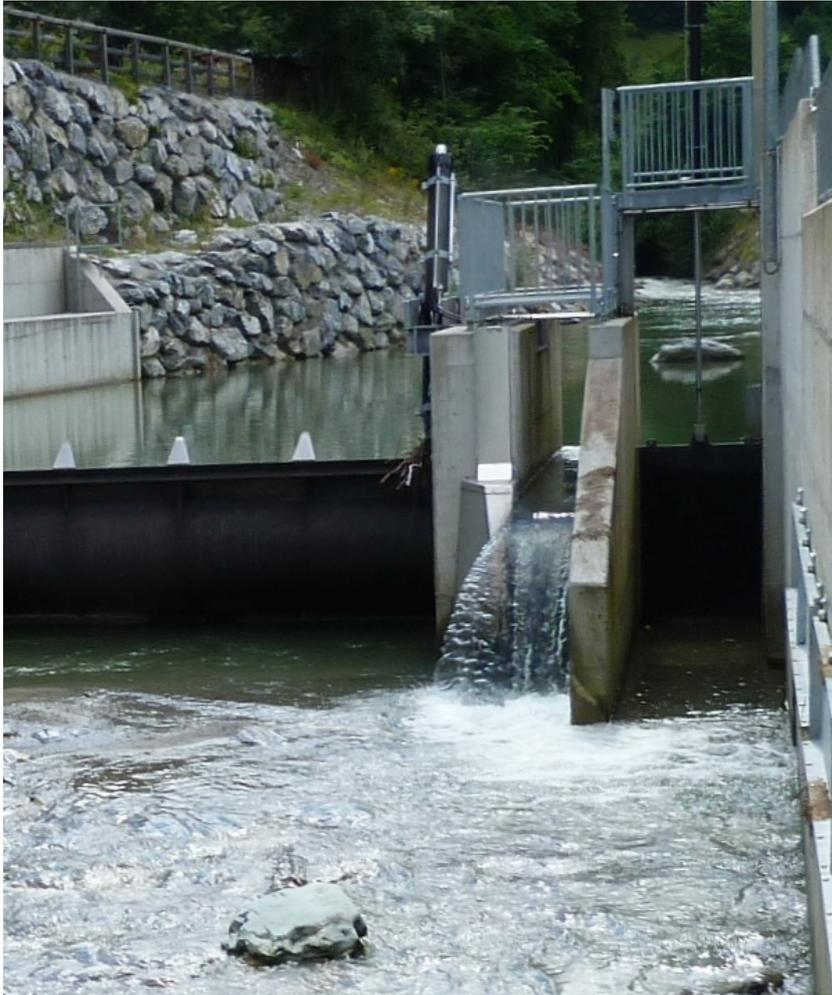
Abbildung 2: Abstiegsklappe/Restwasserklappe an der Wasserfassung des KW Fritzbach.
