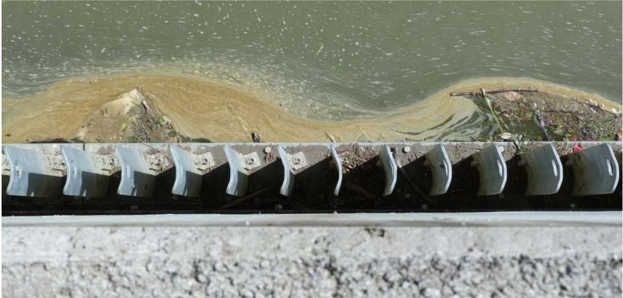
Abbildung 4: Anordnung (LW 15 cm) und Ausformung der Platten für den Louver am KW Fritzbach.
