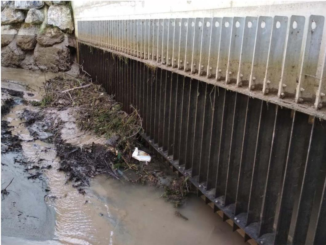
Abbildung 3: Ansicht des (nicht eingestauten) Louvers an der Wasserfassung Hütttau in Richtung stromauf.
