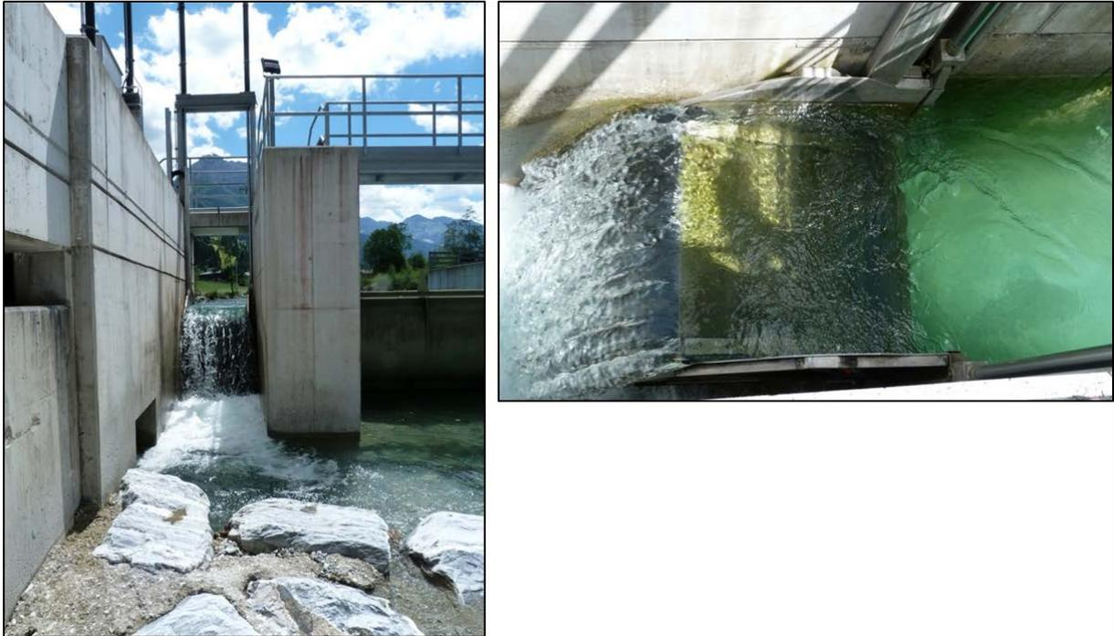
Abbildung 8: Abstieg-/Restwasserklappe an der Wasserfassung des KW Kleinarl.
