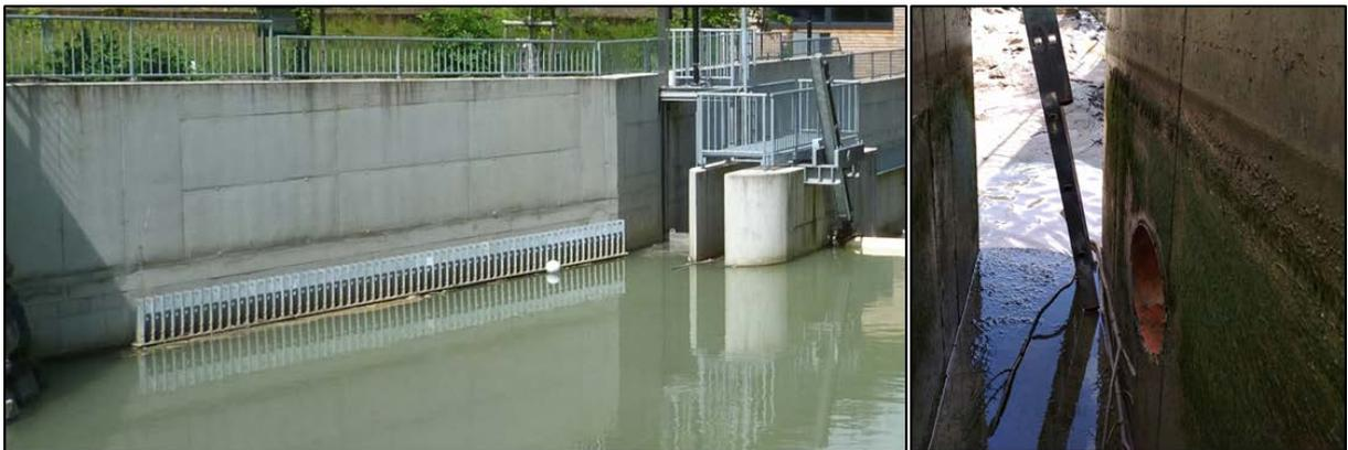
Abbildung 5: (links) Wasserfassung Hütttau mit Louver. Am unteren Ende des Louvers folgt ein Spülschütz sowie (versetzt) der Zulauf zur Abstiegsklappe, (rechts) Rohrdurchlass auf der dem Ufer zugewandten Seite des Zulaufkanals zur Abstiegsklappe.
