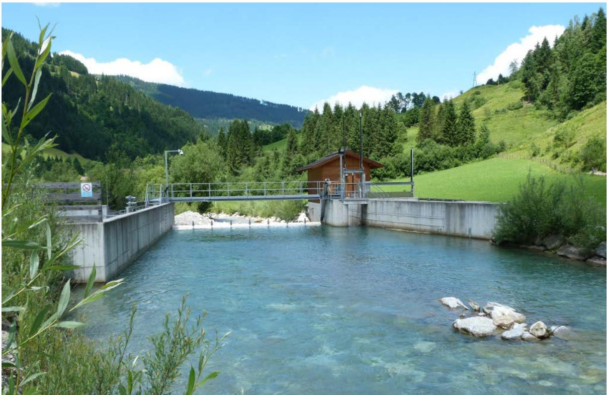
Abbildung 7: Wehranlage des KW Kleinarl. Am linken Ufer ist in die Betonwand der Einstieg in die FAH eingebaut, am rechten Gewässerrand ist die Wasserfassung mit anschließender Abstiegs/Restwasserklappe situiert.
